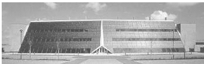
Fig. 6 - Fachada sul do “Solar Office” em Doxford, Reino Unido, com 646 m 2 e uma potência de 73 kWp, sendo previsível uma produção anual de 55 MWh o que representará mais do que um quarto da energia necessária para o edifício.
